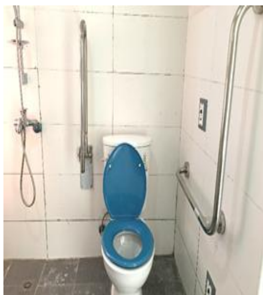
◀ 獨立衛浴設備
